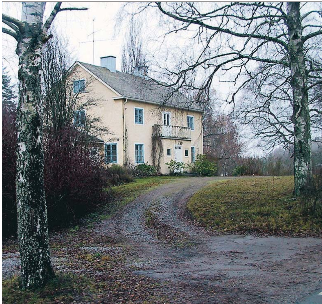
REKTORSBOSTADEN. Kommunen bör vara rädd om huset, och se till att det får behålla sin nuvarande karaktär som en del av Ingesunds skolmiljö även vid försäljningen, anser Irene Heine.
